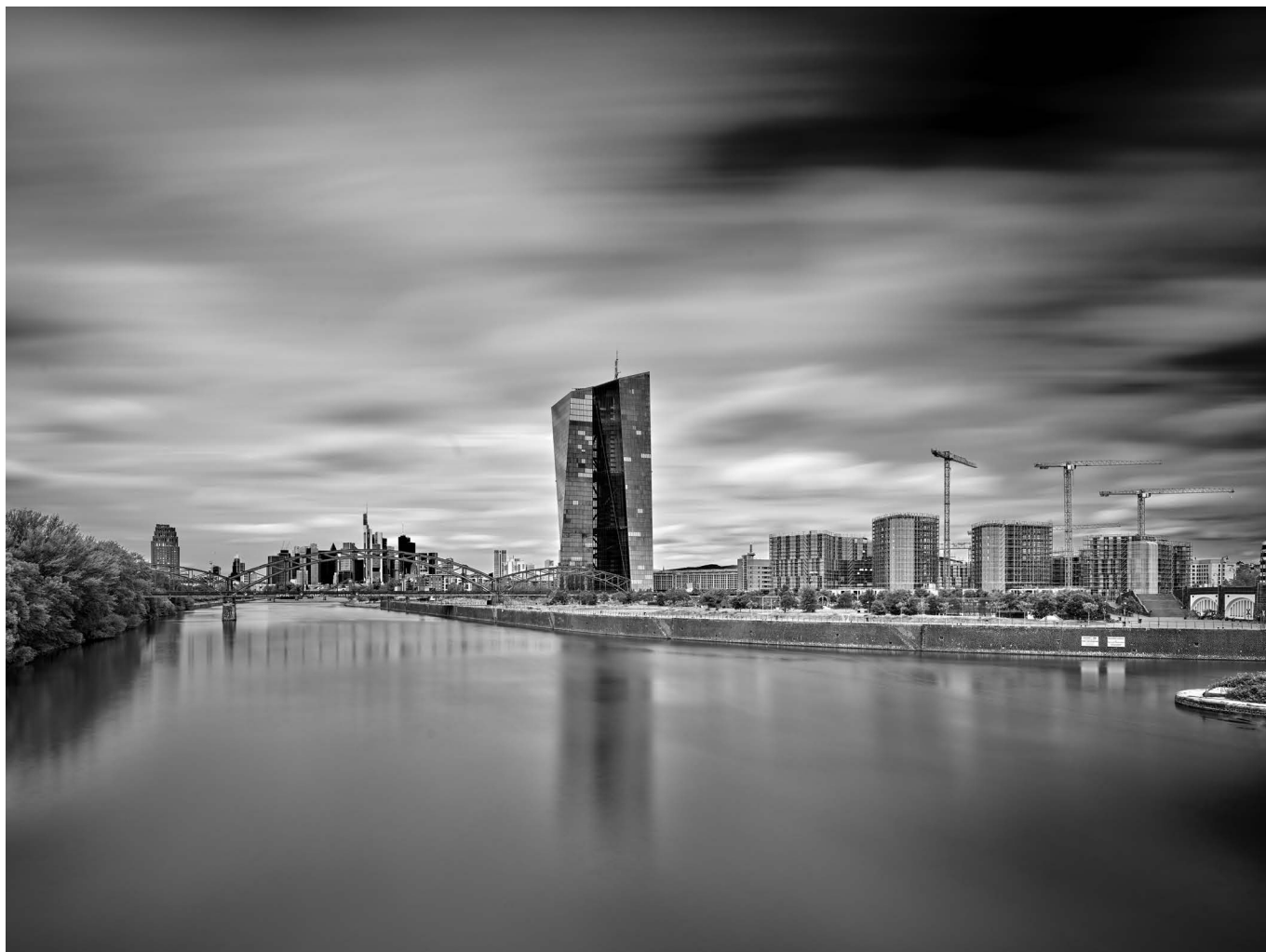
Europäische Zentralbank, Blick von der Osthafenbrücke
